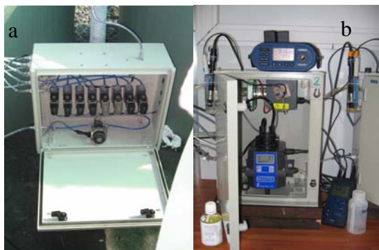
Fig. 2 : Boîtiers électrovannes – pompe (a) et matériel de mesures (b).
