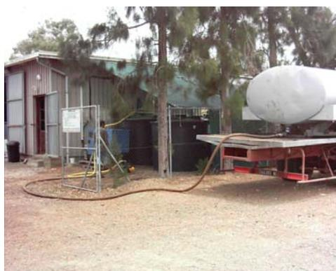
Les 2 cuves fermées de 5 m<sup>3</sup> utilisées pour le traitement de l'eau de mer brute
