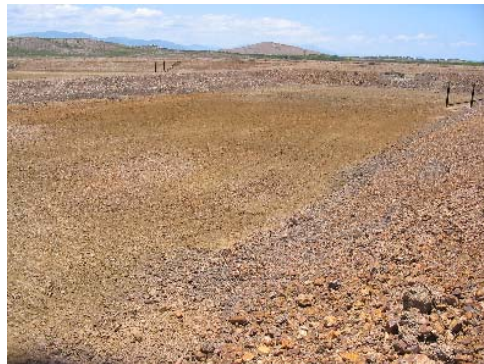
Photo 1 : Exemple d'un bassin de 1460 m 2 à fond de schiste « stérile »
