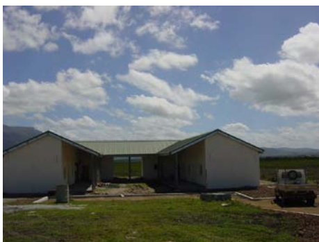
Bâtiment bureaux et laboratoire
